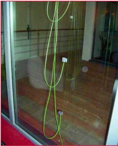
Снимка 3. Температурни сензори от вътрешната страна на стените с прозорци
